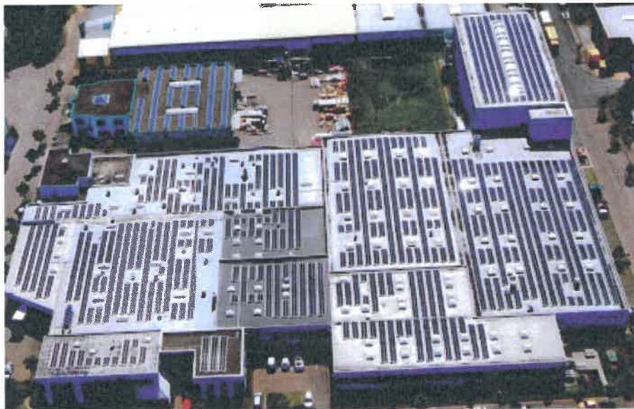
Abbildung 2: Gebäude Saxonia Franke ohne Logistikzentrum
